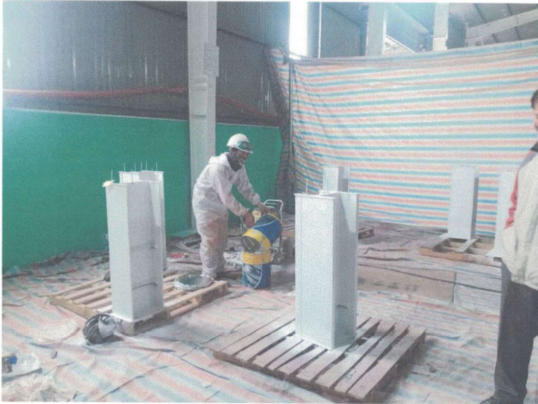
Ảnh G.8: Các mẫu thử được sơn chống cháy
